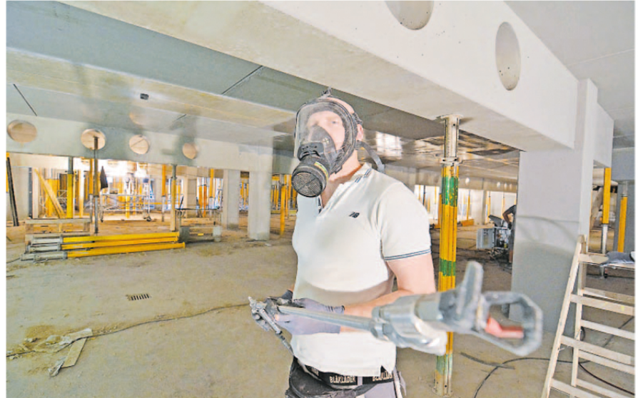
Mit feuerhemmender Farbe besprühen Arbeiter zurzeit Decken und Wände der Tiefgarage unter dem früheren Wölfel-Areal. Wenn diese Arbeit abgeschlossen ist, wird die Haustechnik installiert. Fotos: Thomas Scherer
