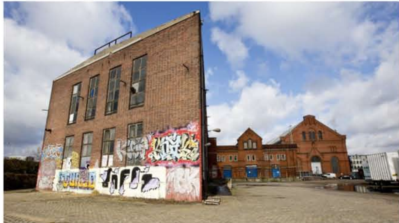
Der Gebäudekomplex des Kraftwerkes Bille
